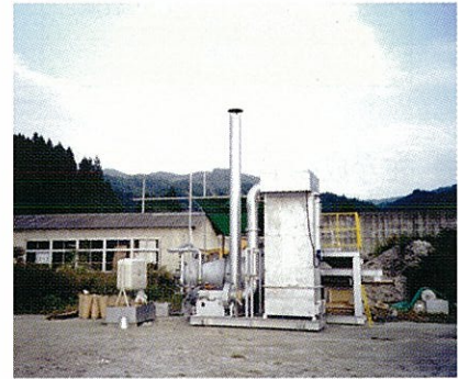
設備設置外観
