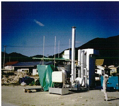
設備設置外観
